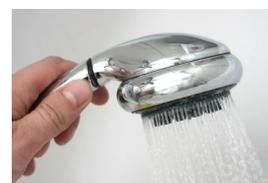
4. **Instala el nuevo cabezal de ducha**. Une manualmente el nuevo cabezal con el brazo de la ducha. Posteriormente gira el cabezal 1 o 2 veces en sentido de las agujas del reloj. Coloca un trapo en el cabezal para protegerlo de las marcas de la llave y ajusta el cabezal.
