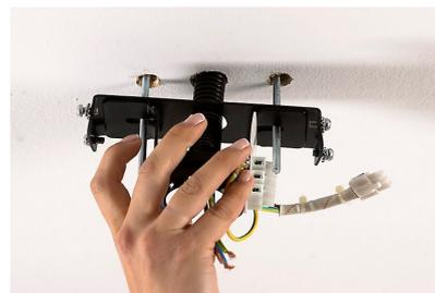
2.4 Con la entrada de luz cortada, **haz la conexión de los cables del punto de luz al ventilador**. Lo normal es a través de clema. Haz que coincidan los colores de ambas partes: fase (negro, gris o marrón), neutro (azul), tierra (verde-amarillo).
