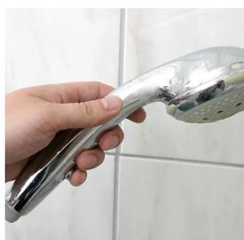
1. **Retira el cabezal de ducha actual** mediante el uso de alicates o una llave. Mantén firme el brazo de ducha (tubo) y afloja la tuerca que está detrás del cabezal de la ducha. Finalmente retira la tuerca con los dedos y saca el cabezal de ducha.
