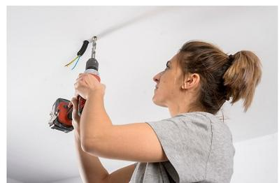
2.3 Introduce el soporte por las varillas y atornilla hasta que el taco aprisione con fuerza la cara interior del techo hueco, de escayola o cartón yeso.
