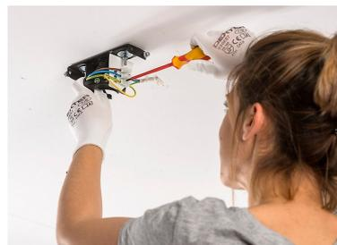
2.5 **Cuelga el ventilador en el soporte**, ajustándolo en el hueco. Haz las conexiones eléctricas. Después, termina la instalación fijando la carcasa con los tornillos laterales. La carcasa oculta los mecanismos y evita que se salga del gancho del soporte.
